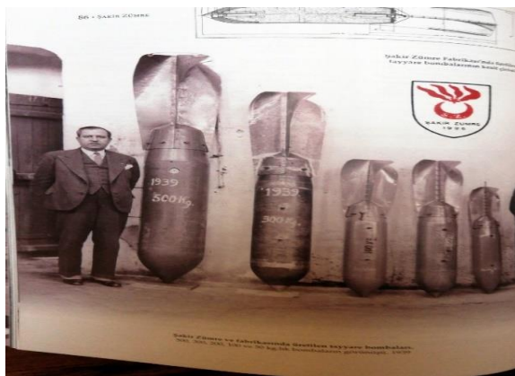
Şakir Zümre’nin Fabrikalarında Üretilen Tayyare Bombaları
